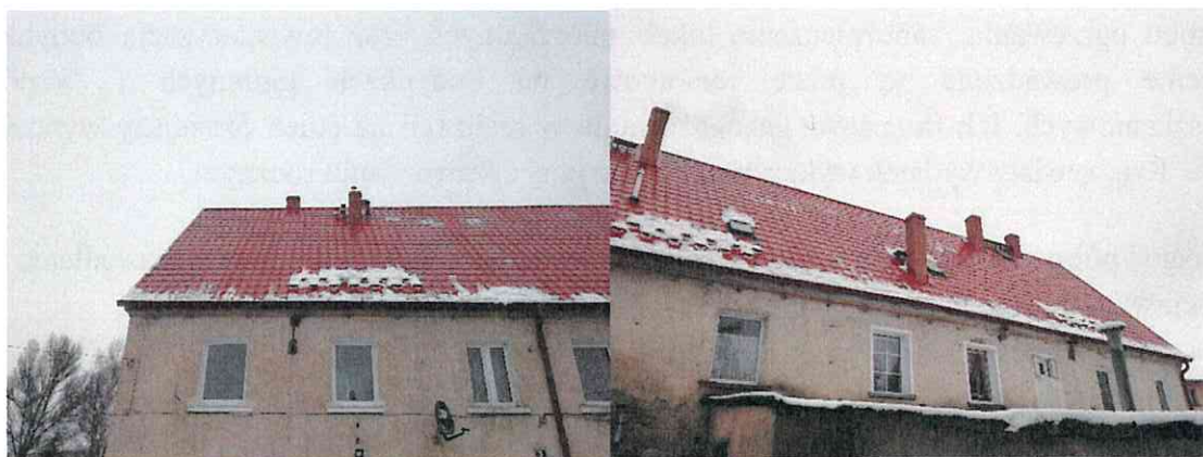
ul. Leśna 3 – dach po remoncie
