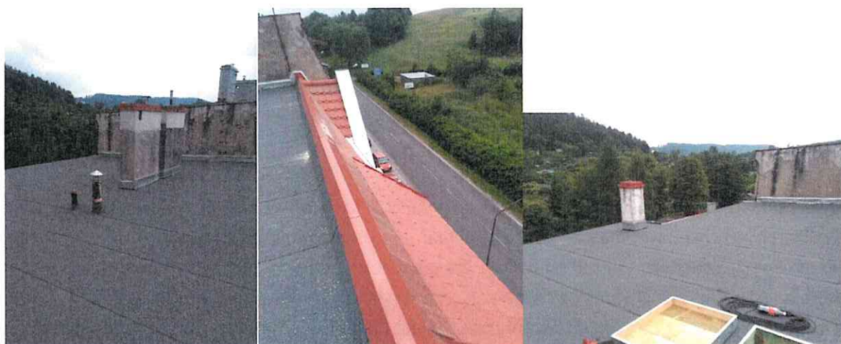
ul. Lubawska 23 – remont dachu
