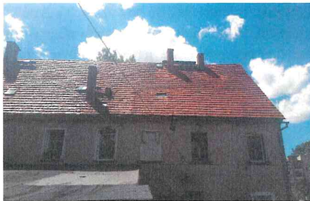
ul. Leśna 3 – dach przed remontem
