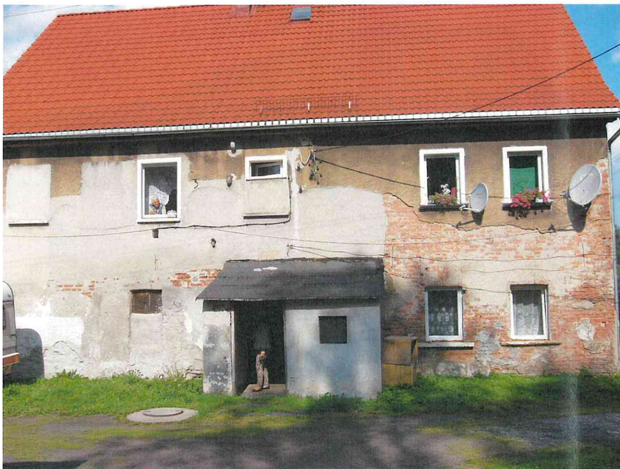
Budynek komunalny ul. Wiejska 21 Kamienna Góra – przed remontem
