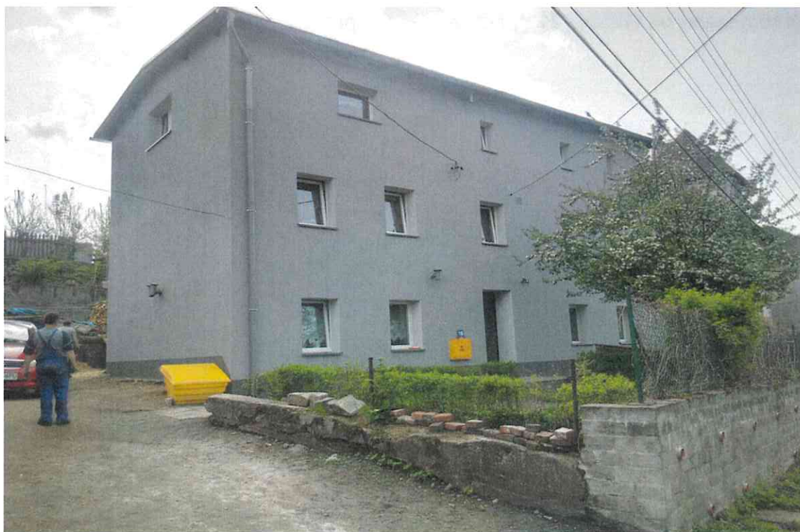
Budynek komunalny ul. Ptasia 10 – po remoncie
