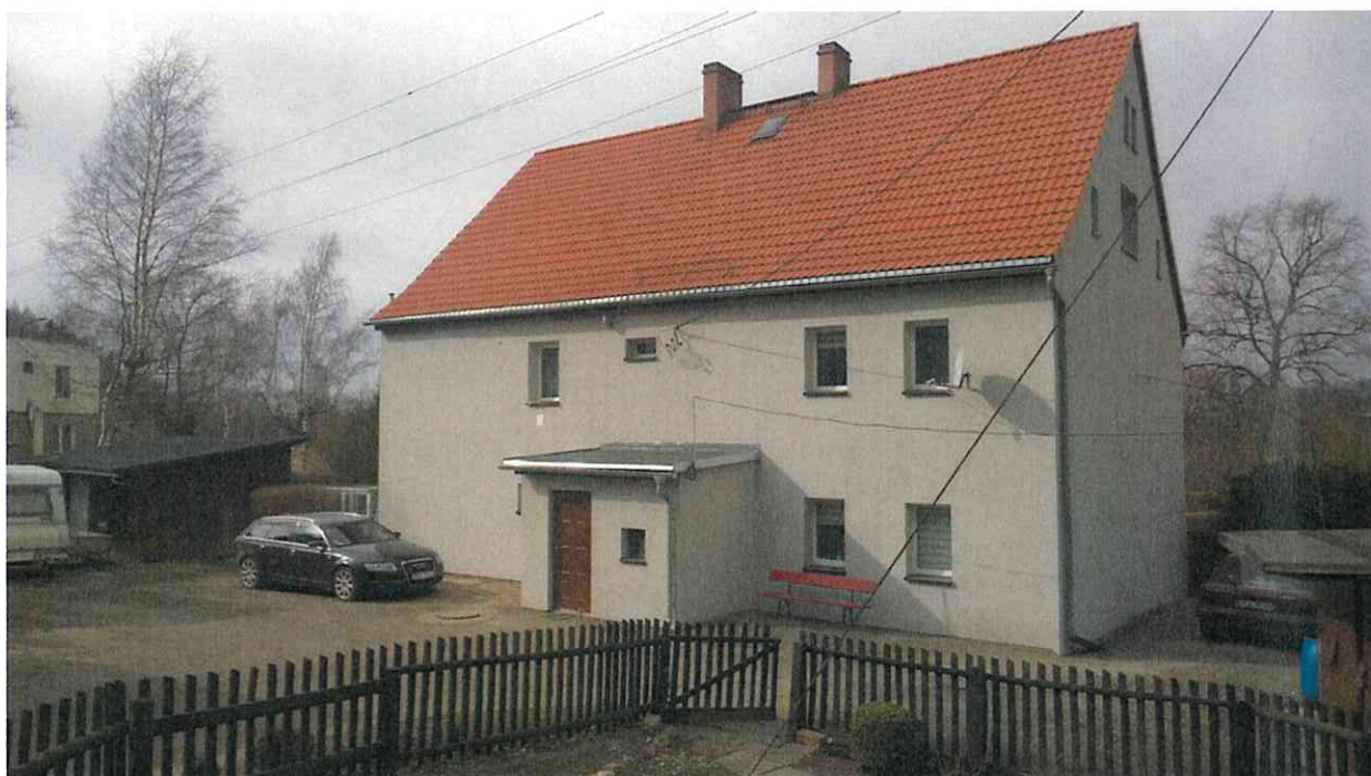
Budynek komunalny ul. Wiejska 21 Kamienna Góra – po remoncie
