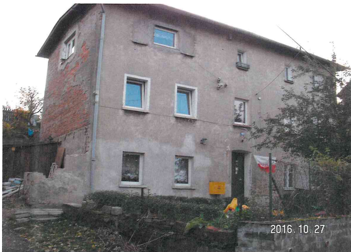
Budynek komunalny – ul. Ptasia 10 Kamienna Góra – przed remontem
