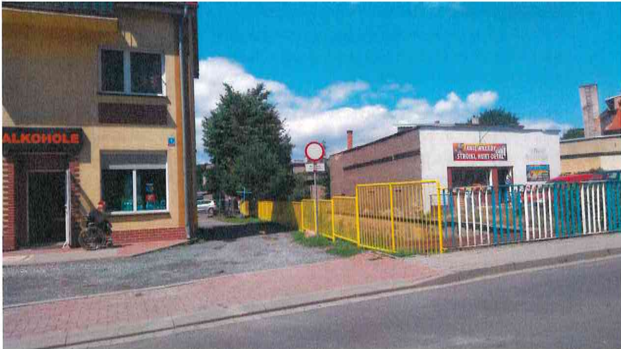
Wymiana ogrodzenia – ul. Katowicka
