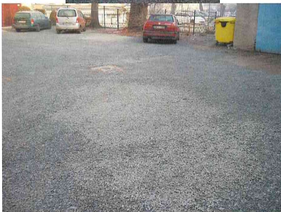
Utwardzenie terenu – ul. Kościuszki 1
