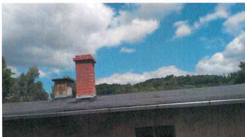
Dach – ul. Leśna 1 – przed i po remoncie
