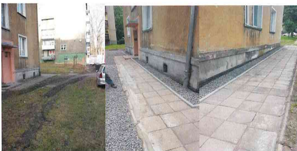
Drenaż i odwodnienie – ul. M. Skłodowskiej-Curie 33 – przed i po
